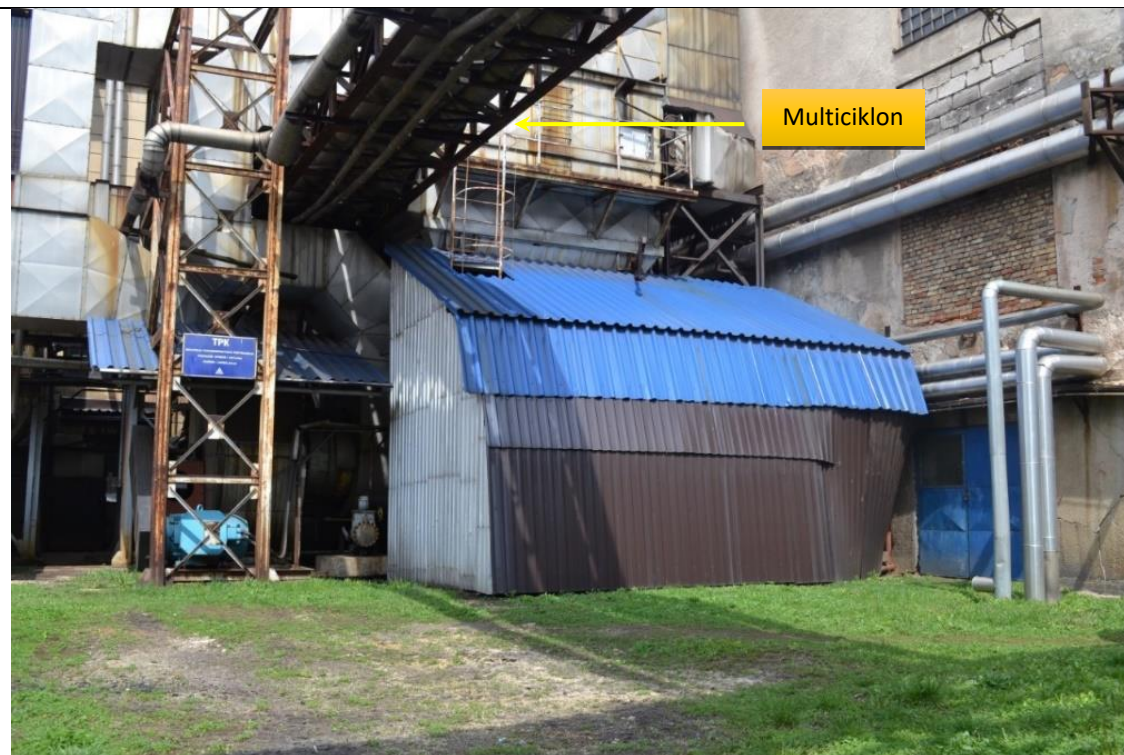
Slika 3. Dio multiciklona za odvajanje prašine iz dimnih gasova
